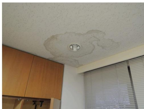
館長室の角に雨漏りが過去に発生。一部の収納スペースに影響している。
